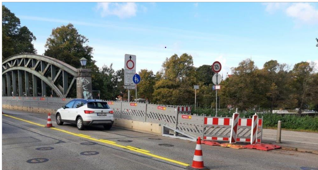
Abb.: BW 007 Hüntertorbrücke – Lastreduzierung
